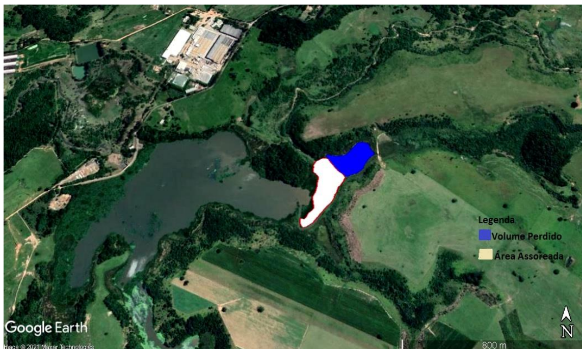
Figura 28 – Área comprometida do reservatório
