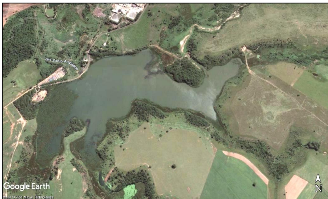
Figura 26 – Condição do Reservatório no ano de 2015
