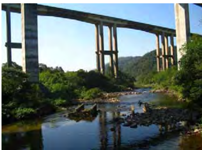
Figura 2 – Rodovia dos Imigrantes entrecortando a área do PESM (Fonte: Acervo Núcleo Itutinga-Pilões)
