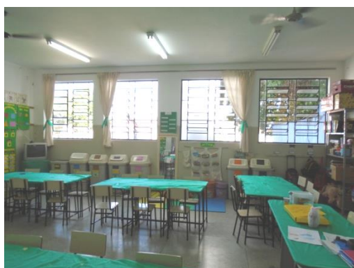
Figura 72 – Janelas da sala de aula
