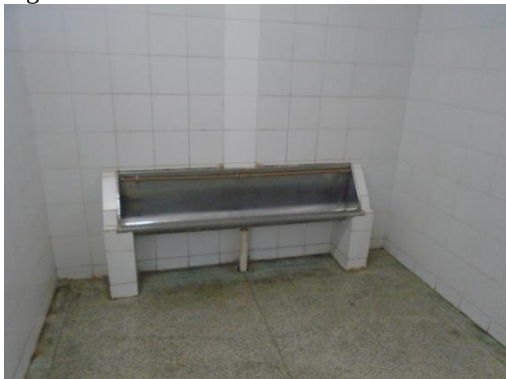
Figura 28 – Mictório do banheiro 1
