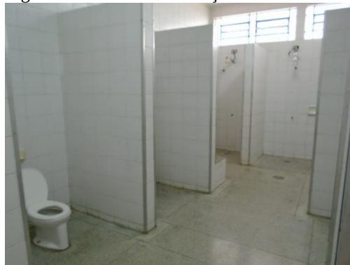
Figura 29 – Área de circulação do banheiro 1
