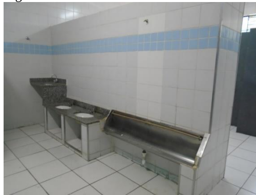
Figura 36 - Mictório e lavatórios do banheiro 2
