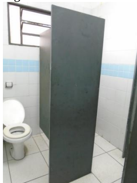
Figura 38 – Vaso sanitário do banheiro 3
