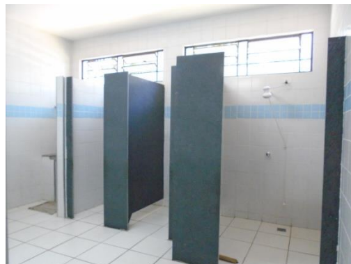
Figura 34 – Chuveiros do banheiro 2
