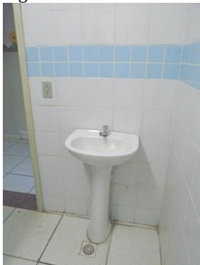
Figura 37 – Lavatório do banheiro 3
