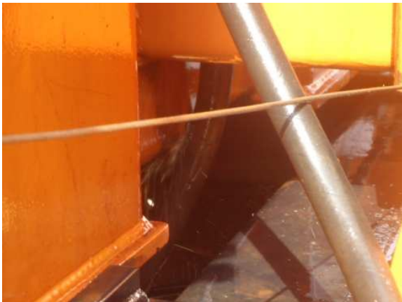
Figura 7 – Vazamento do caminhão munck
