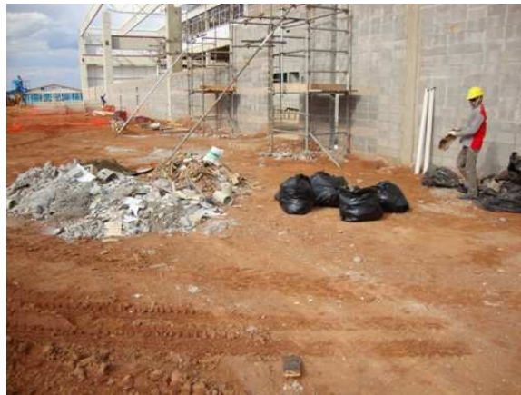
Figura 21 – Local de armazenamento de entulho
