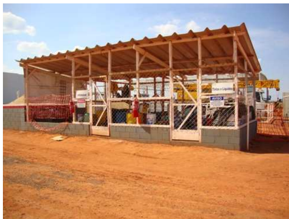
Figura 14 – Local de armazenamento de inflamáveis, tintas e solventes para tinta
