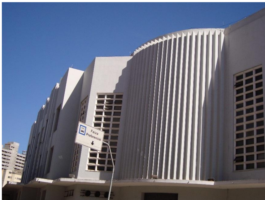
Figura 14 - Detalhe da fachada lateral do Cine-Teatro Goiânia, atual Teatro Goiânia, 2015. Foto: Antonio de Lion. Fonte: Acervo do autor.
