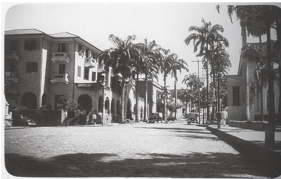
Figura 05 - Avenida Getúlio Vargas, década de 1940. Ao lado esquerdo vê-se o Grande Hotel. Autoria desconhecida. Fonte: FREITAS, Maria Auxiliadora de, op. cit., p. 218.
