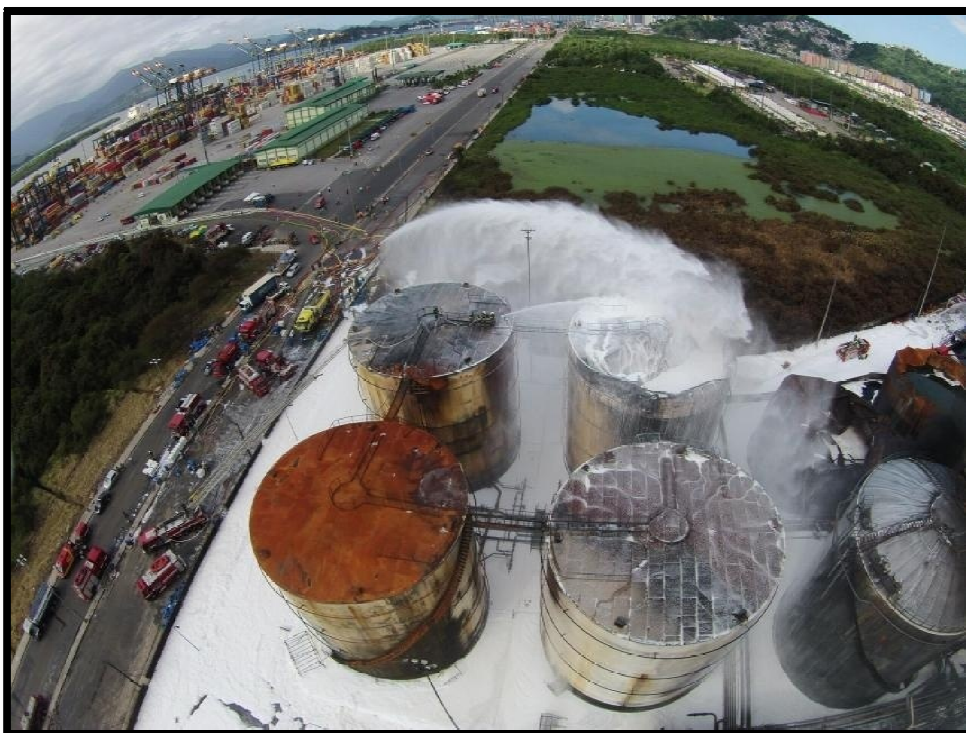
Figura 8 – Combate ao Incêndio ocorrido no Terminal Petroquímico da Ultracargo em 2015, liberação de grande volume de LGE - AFFF e Isolantes Térmicos, Santos –SP. Foto: Diego Lameiro/ Corpo de Bombeiros da PMESP.
