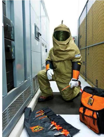
Figura 9 – Exemplo de vestimenta utilizada para proteção contra arco elétrico
