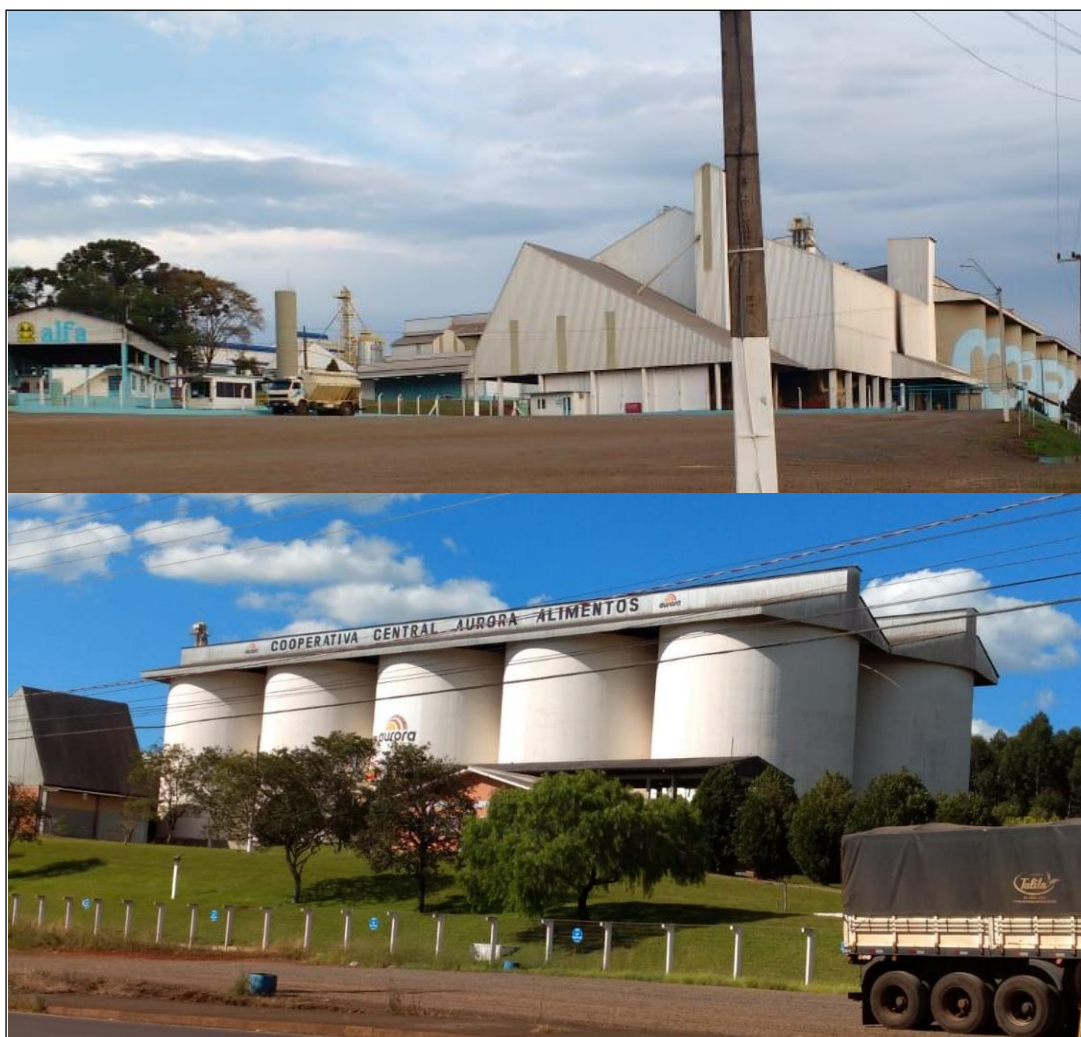
Figura 79 – Unidade de armazenamento da Cooper Alfa e da Aurora em Chapecó
