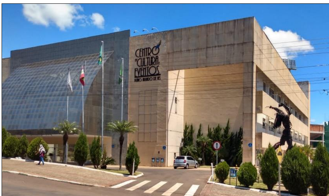
Figura 90 – Chapecó: Centro de Eventos Plínio Arlindo de Nes
