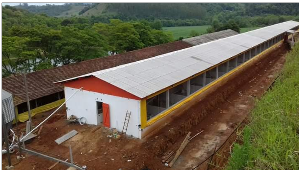
Figura 53 – Galpão para terminação de suínos em construção
