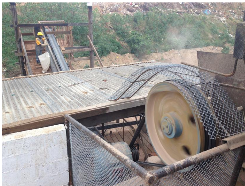
Figura 15 – Funcionário operando na separação manual na transportadora de correia no Parque Santa Luzia.
