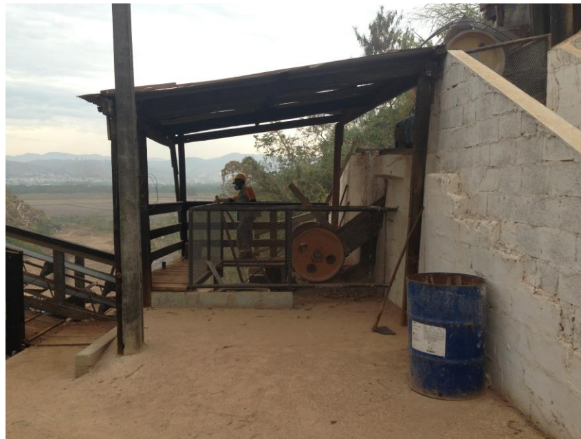
Figura 14 – Operador de máquinas trabalhando no britador no Parque Santa Luzia.
