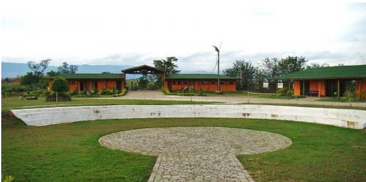
Figura 8 – Local do antigo lixão de Guaratinguetá-SP que foi transformado no Parque Ambiental Santa Luzia.
