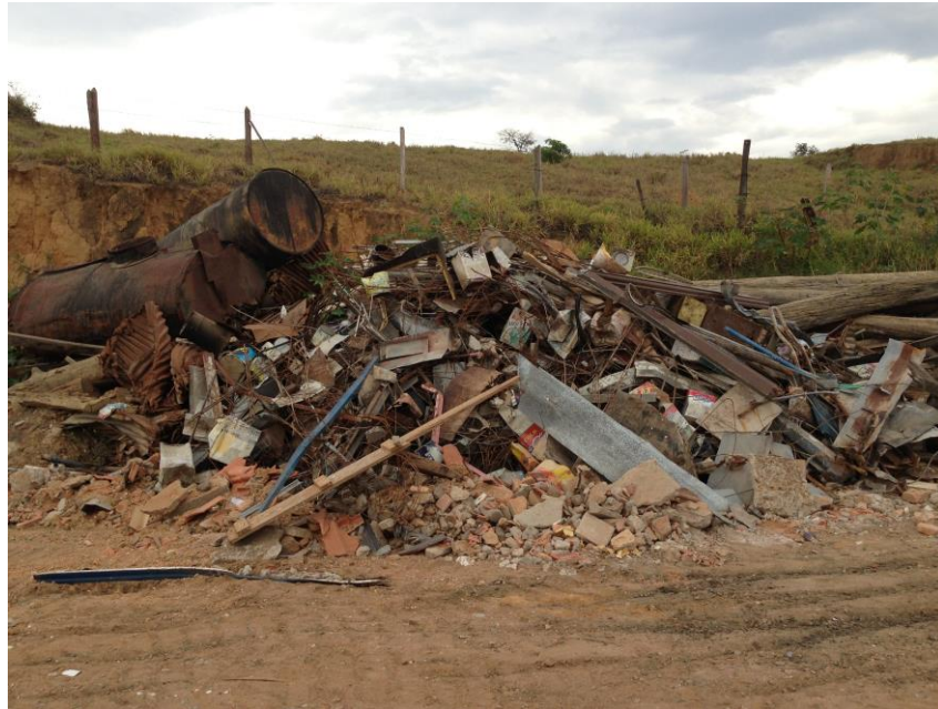
Figura 12 – Entulho não reaproveitado.
