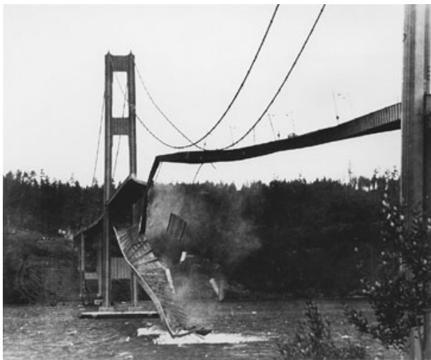
Figura 1.1 Colapso da ponte Tacoma Narrows
