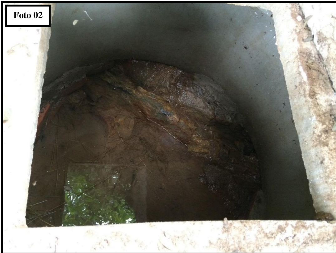
Caixa de Concreto aberta e a nascente (foto 02)
