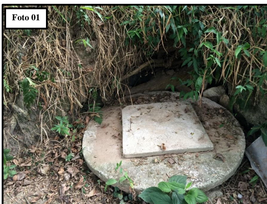
Caixa de Concreto fechada para a proteção da nascente (foto 01)
