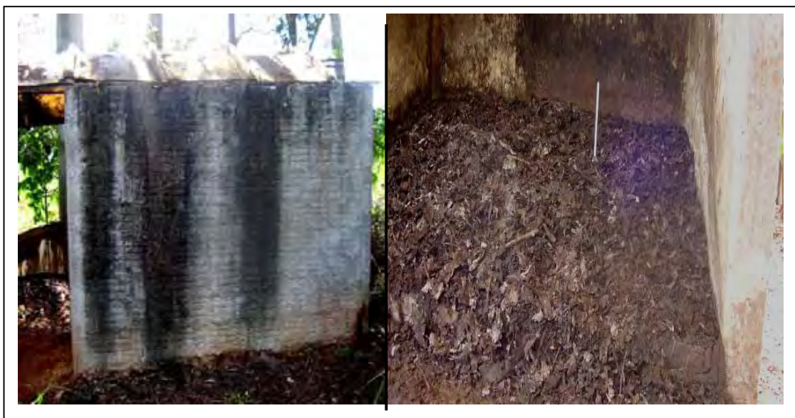
Figura 13: Local onde foi colocado o material a ser compostado e uma de suas divisões.
