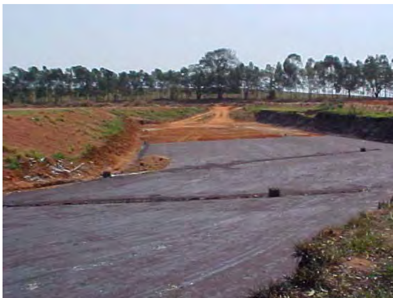
Figura 4: Fotografia do aterro sanitário de Bauru-SP (LOPES, A.A. Tipos de Aterros de Resíduos Sólidos).
