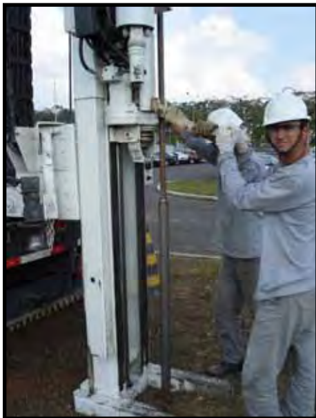
Foto 2 - Geoprobe com amostrador.
