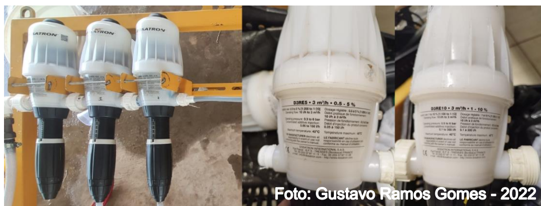
Figura 6 - Dosadores D3RE5 (1 e 2) e D3RE10 (3) posicionados em série
