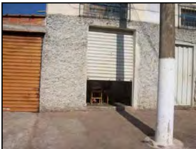
Figura 4 – Banca de Pesponto em Local Improvisado na Cidade de Franca (SP)
