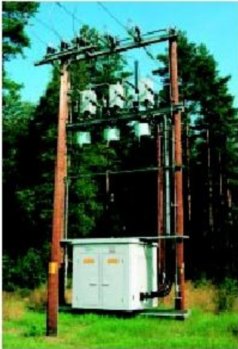
Figura A.4 - Minicap da ABB, projetado para suportar alimentadores até 36kV
