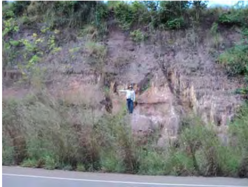
Figura 14: Conjunto de falhas normais formando pares conjugados e estruturas em graben, horste e bloco abatido à direita, afetando sedimentos da Formação Barreiras (Rodovia Transamazônica).
