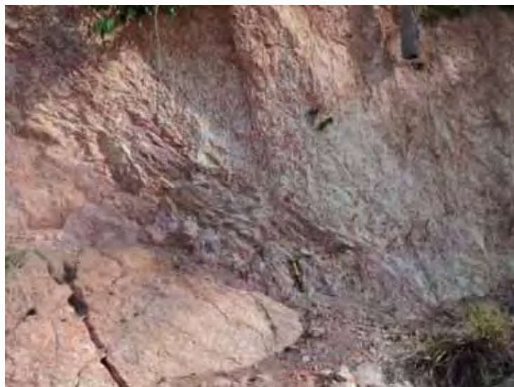
Figura 27: Zona de “caixa de falha” de movimentação inversa no afloramento 23, afetando rochas graníticas alteradas e, principalmente, material argilo-arenoso com alteração de horizonte plíntico (ou mosqueado). Os planos de falhas mergulham com baixo ângulo para NW.
