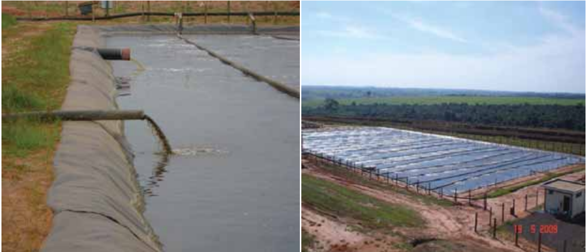
Figura 6: Lagoa de Aeração entrada do efluente e vista aérea Autor: Renato Vessecchi Lourenço.
