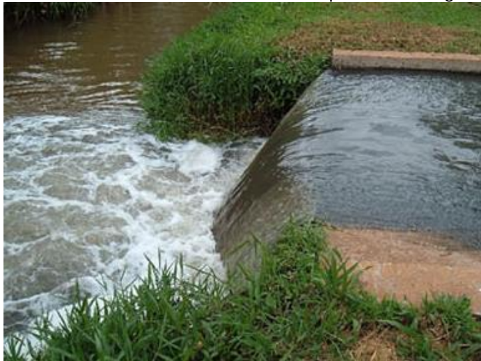
Figura 6 - Lançamento do efluente tratado da ETE Araraquara no córrego Ribeirão das Cruzes
