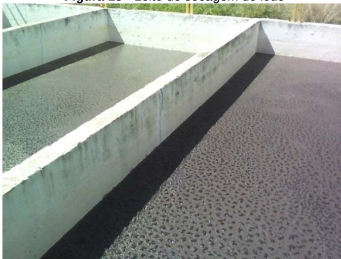
Figura 13 - Leito de secagem de lodo
