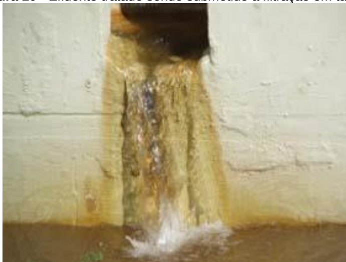
Figura 10 - Efluente tratado sendo submetido à filtração em tanque
