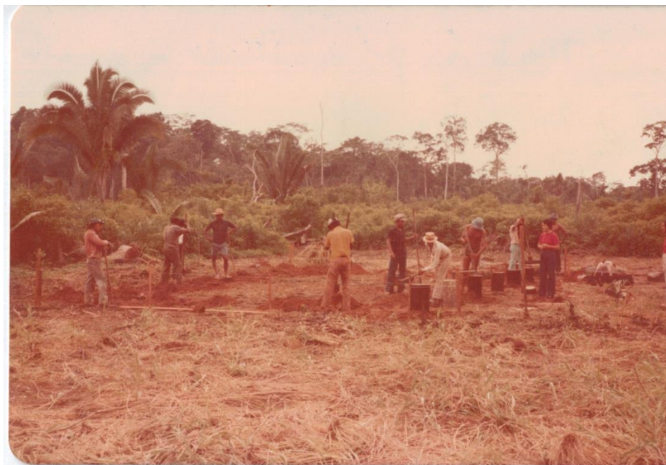
Figura 10 - Mutirão para construir a Escola Dirce Maria da Cunha
