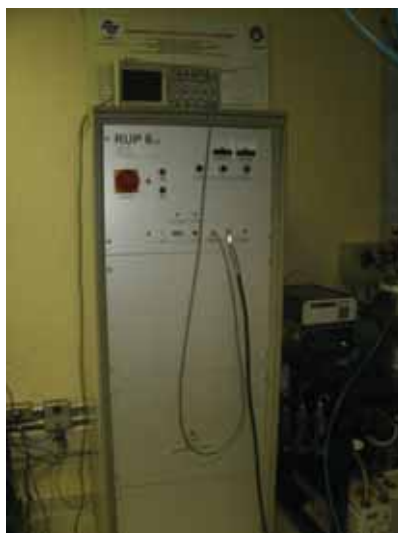
Figura 23- Fonte geradora de pulsos negativos
