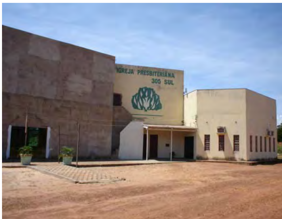
Figura 53: Igreja presbiteriana na Quadra 305 Sul. Fotografia tirada em 12 de janeiro de 2007.
