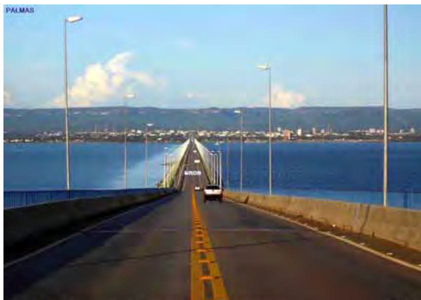
Figura 62: Ponte FHC (Palmas - TO). Fotografia de Thenes Pinto, 2007.
