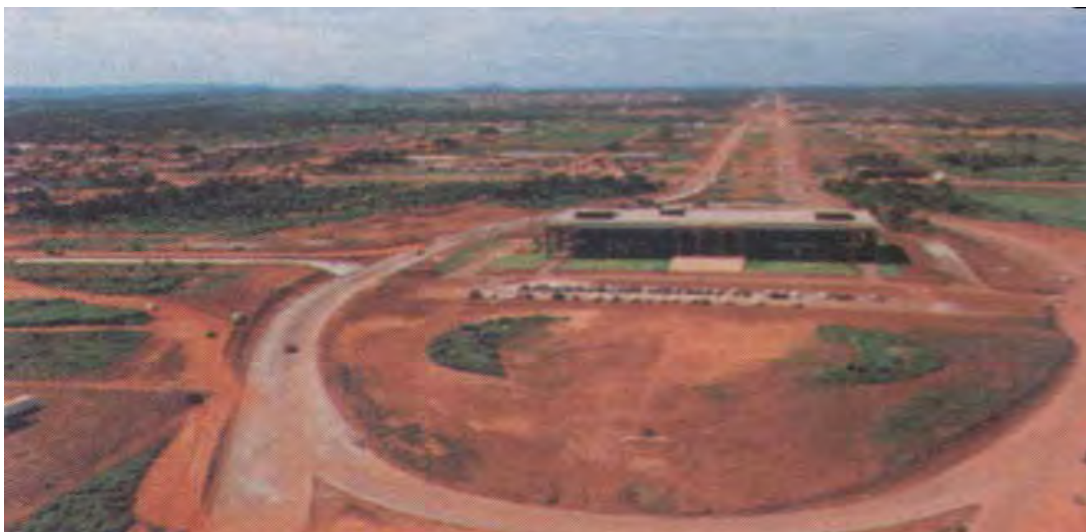
Figura 20: Início da construção de Palmas.
