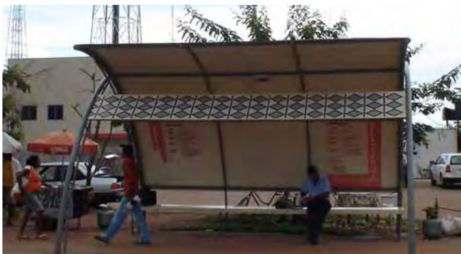
Figura 83: Estação Apinajé. Fotografia tiradas em fevereiro de 2008.
