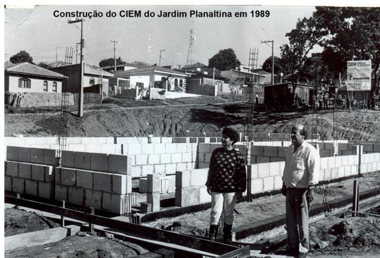
Figura 17 - Construção do CIEM do Jardim Planaltina em 1989 49 .
