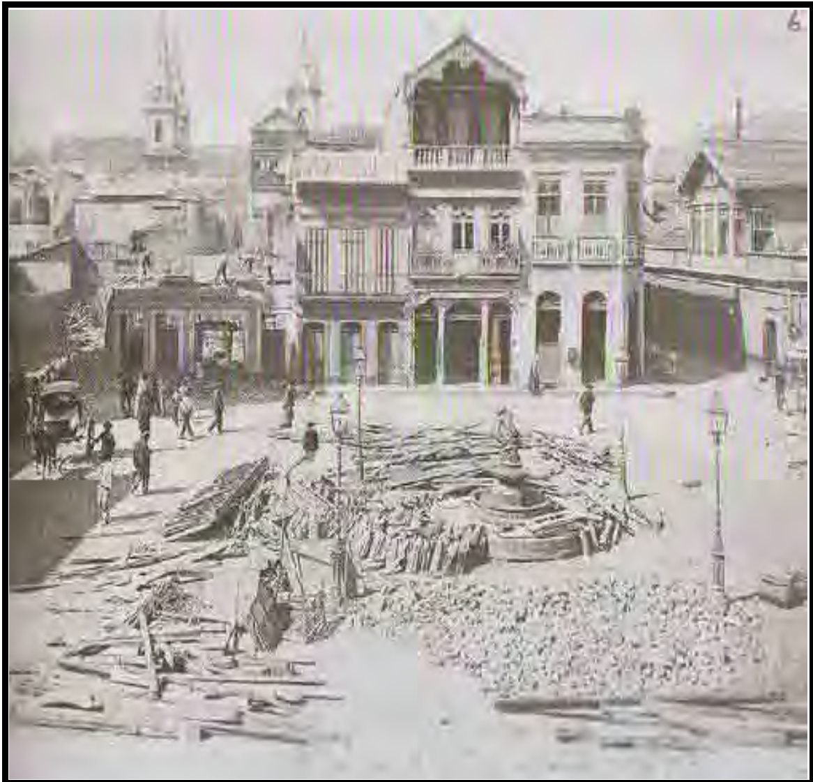
Figura 36 Abertura da Avenida Passos. 27
