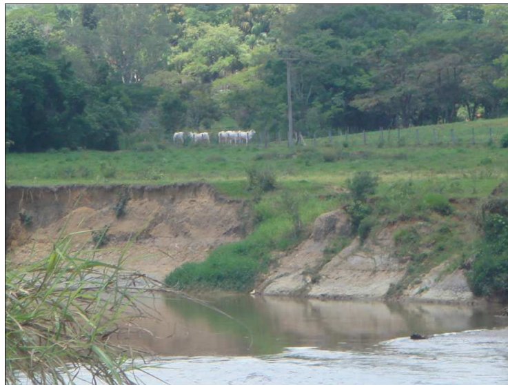
Figura 24: Trecho demonstrado na Imagem 13 ampliado detalhando o processo erosivo na margem do rio Camanducaia na AEU-03.
