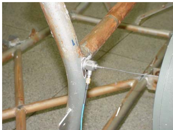
Figura 6.35 – Acoplamento Shaker- Estrutura.
