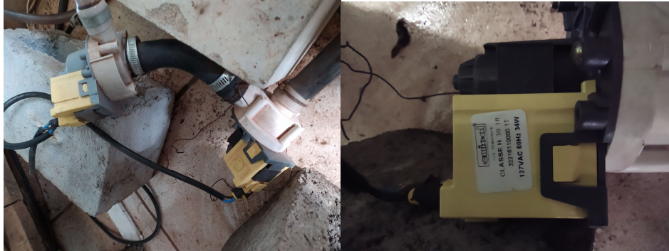
Figura 14. Conjunto de duas eletrobombas de 34w cada, para recircular a água no sistema
