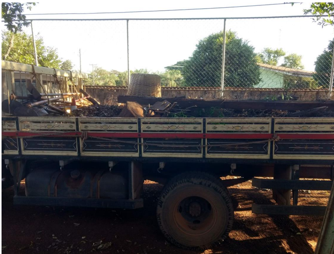
Figura 11 - Caminhão de entulho sendo retirado da escola
