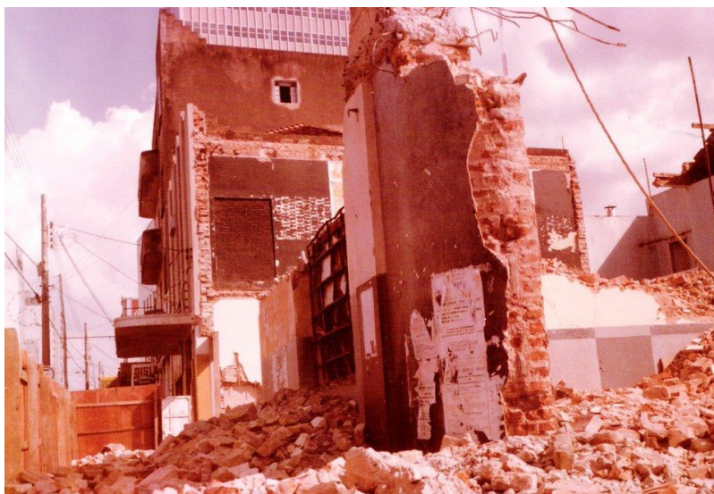
Figura 10. Demolição Cine Marília
