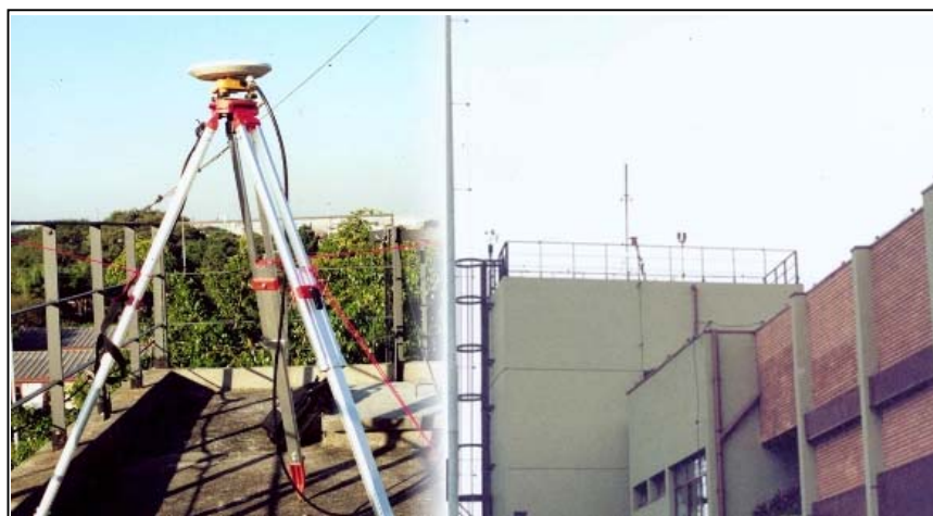
Figura 8.5. Fotografia da antena GPS instalada sobre a caixa d'água do prédio da INFRAERO. No detalhe são mostradas a antena e a chapa que materializa a estação SAOP.
