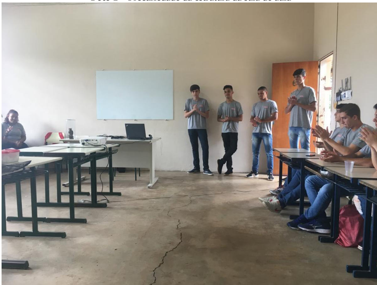
Foto 1 – Precariedade da estrutura da sala de aula
