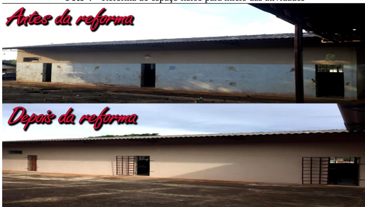
Foto 4 – Reforma do espaço físico para início das atividades
