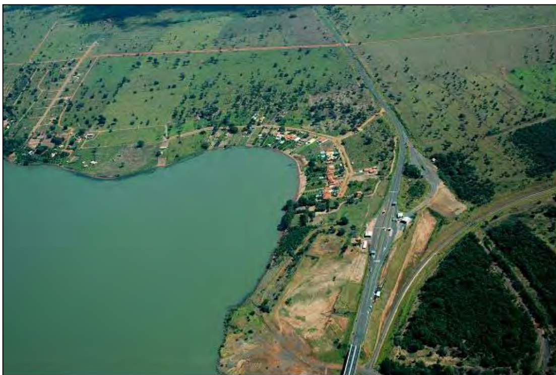
Figura 14 – Foto aérea da margem direita do reservatório (Aparecida do Taboado-MS) , ilustrando a ocupação em Área de Preservação Permanente (APP). Fonte: Arquivo pessoal, 2006.
