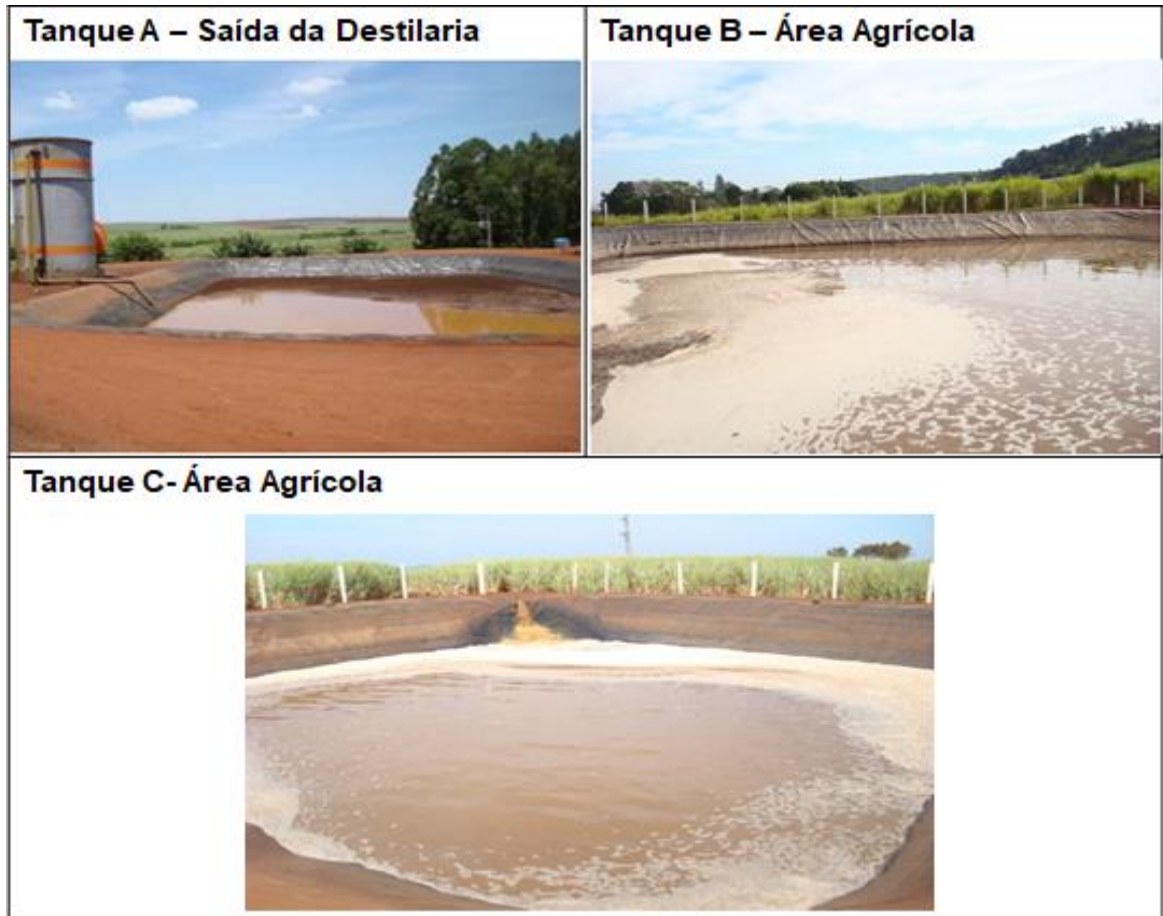
Figura 4. Tanques de armazenamento de vinhaça da usina sucroalcooleira (ARCADIS TETRPLAN, 2011; PLANO DE APLICAÇÃO DE VINHAÇA, 2017).
