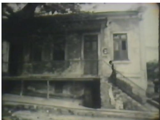
Figura 18. A escada da casa de Raul.
