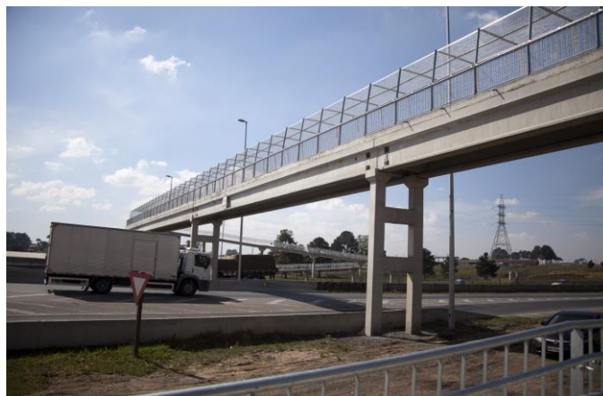
Figura 10 - Passarela de pedestres em vigas pré-moldadas protendidas
