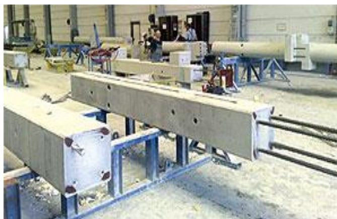
Figura 7 - Linha de produção de pré-moldados na Bélgica, as fábricas investem alto nos sistemas de fôrma, cura e protensão.
