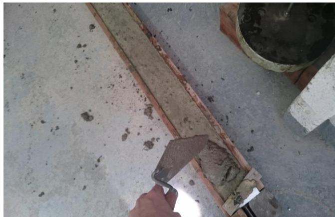
Figura 28 - Graute sendo colocado na forma de madeira.
