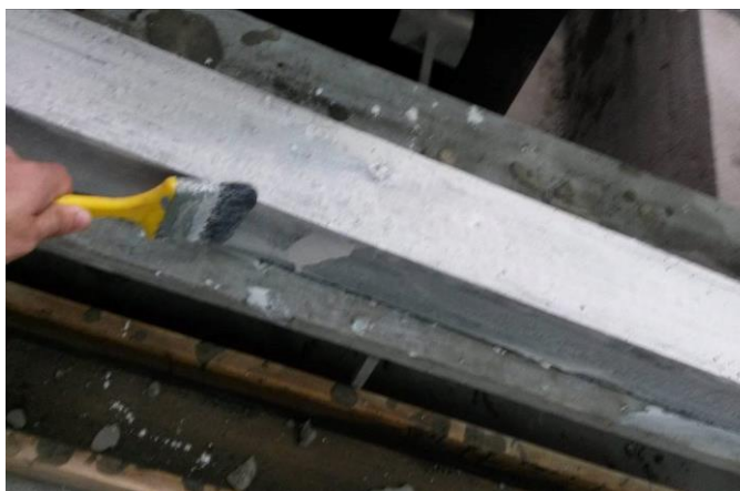
Figura 30 - Viga sendo pintada com cal branca para pintura básica.
