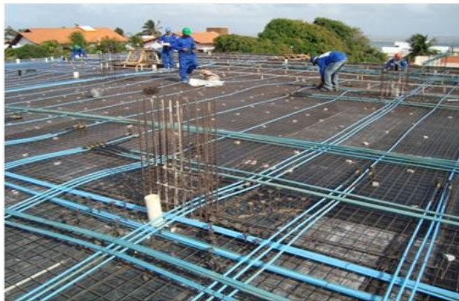
Figura 5 - Cabos de protensão sendo distribuídos numa laje cogumelo.
