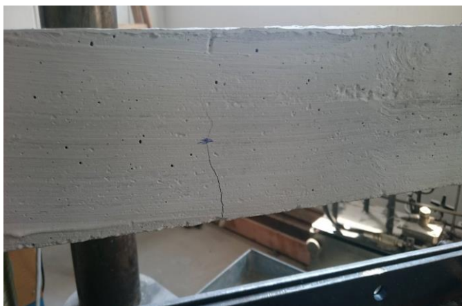
Figura 48 - Fissurações do lado oposto da viga à 0,26 tf.
