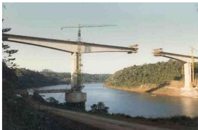
Figura 2 - Ponte protendida em balços sucessivos.
