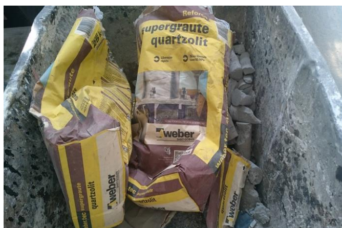
Figura 23 - Material Supergraute utilizado para fazer a viga.
