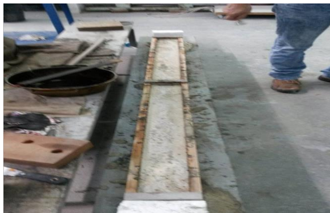
Figura 29 - Viga na forma antes de curar
