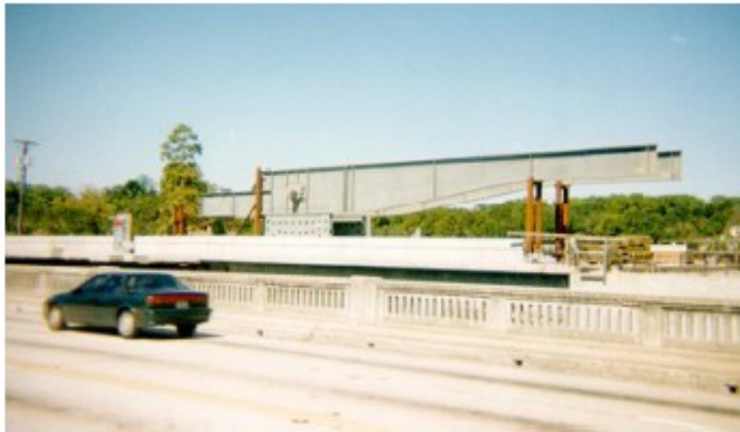
Figura 2.9: Ponte basculante da Florida(EUA)
