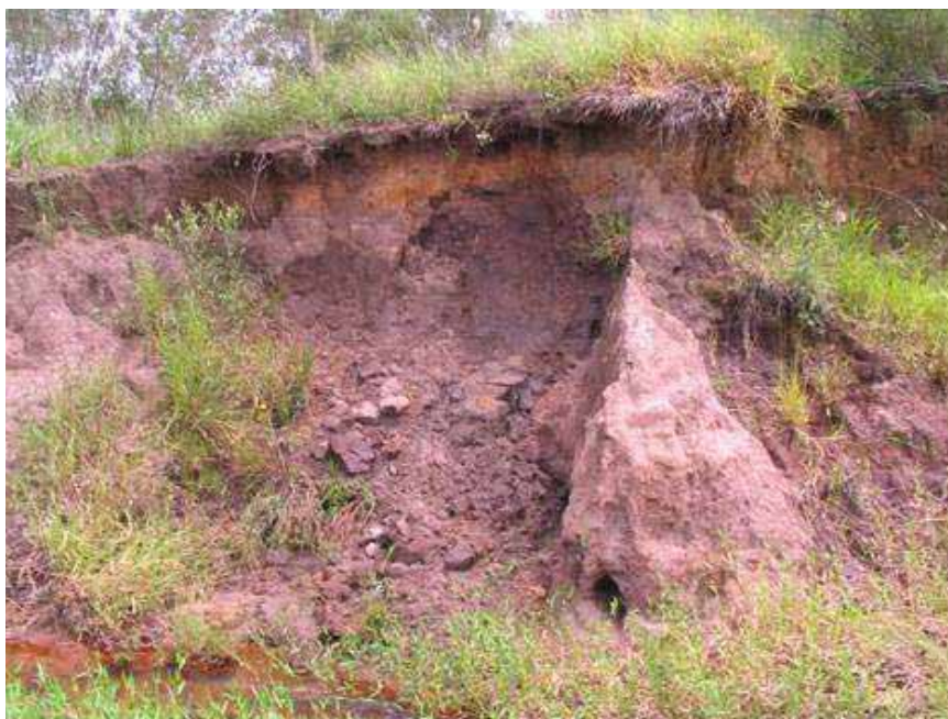
Figura 39: Erosão de margem de rio observada na microbacia 1015, também devido à ausência de mata ciliar nas coordenadas nas coordenadas UTM N=213.888,309m e E=7.120.056,603m.
