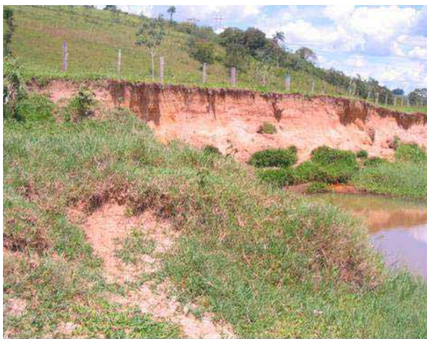
Figura 38: Erosão de margem de rio, observado na microbacia 142 devido, principalmente à ausência de mata ciliar nas coordenadas UTM N=217.834,946m e E=7.532.039,702m.
