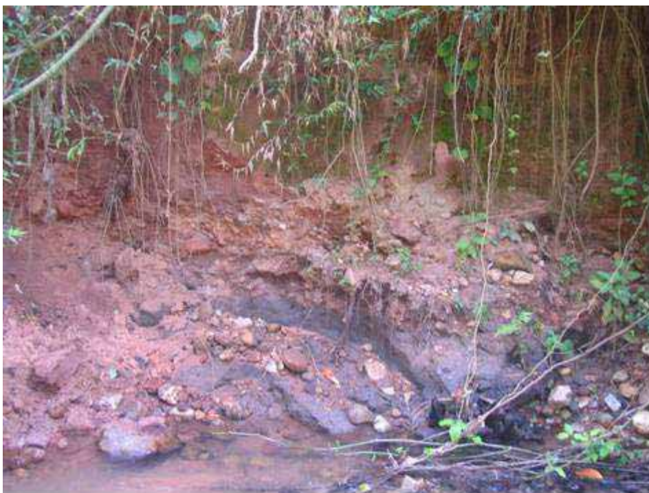
Figura 37: Erosão fluvial, decorrente da ação do fluxo do canal em épocas de cheia, na microbacia 634, nas coordenadas UTM N = 227.393,528m e E = 7.500.505,409m.
