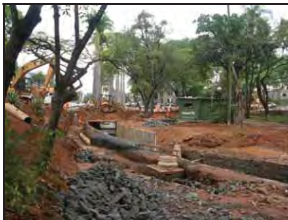
Figura 35 – Obras no córrego do Parque na Praça Parque Real. Foto: Marcelo R. de Ávila, 2011.
