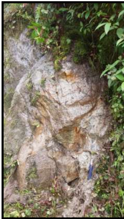
Figura 28: Zona de percolação de água em gnaisse
