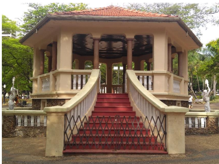
Figura 34 - Coreto da praça central de Pirassununga restaurado
