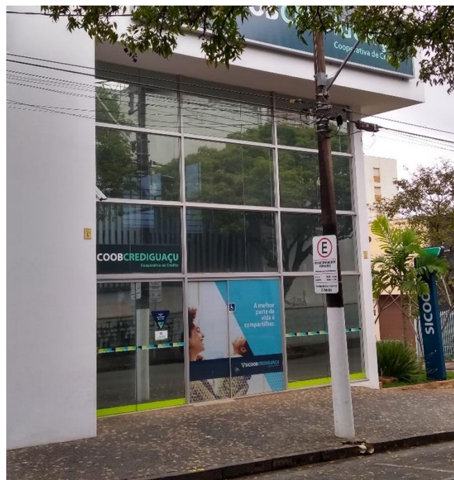
Figura 22 - Cooperativa de crédito após demolição
