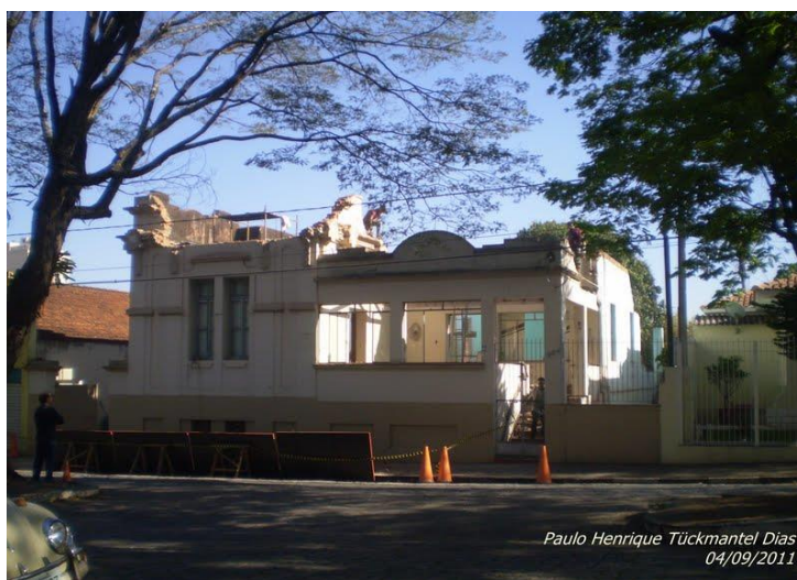
Figura 19 - Casa com arquitetura do início do século XX ao lado da Igreja Matriz sendo demolida em 2011
