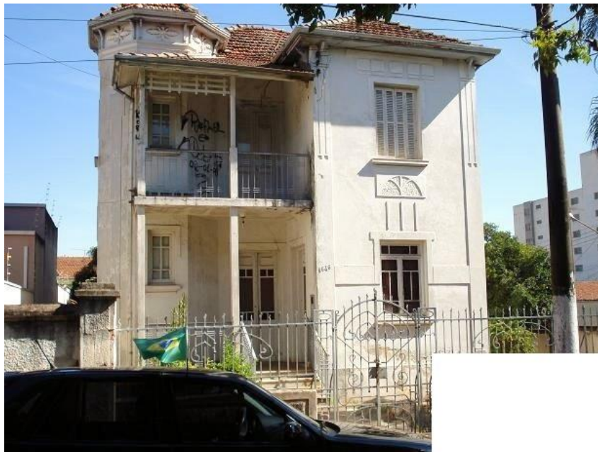
Figura 21 - Antigo sobrado que foi demolido
