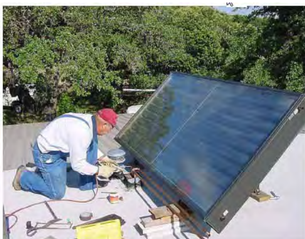
Figura 6: Coletor solar de placa plana.
