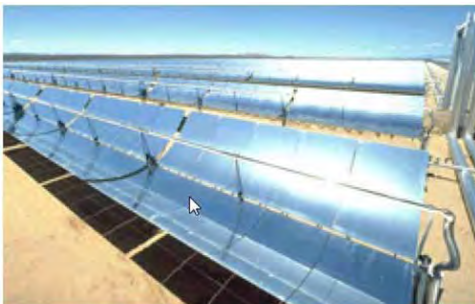
Figura 7: Coletor solar cilindro-parabólico.
