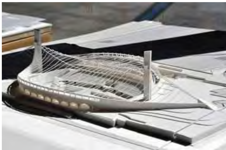
Figura 31: Maquete representando a parte das colunas e o eixo criado pelos cabos fixados no chão. Fonte: arenasindex.com
