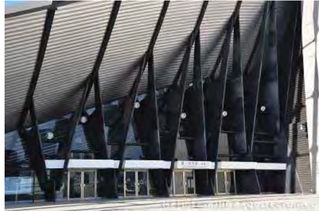
Figura 37: Vigas em "V". Fonte: flirckr.com/kenzotange
