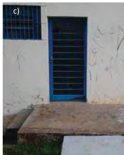
Imagem 9: a) Entrada do ginásio ao fundo mostrando o caminho estreito e sem nenhum tipo de cobertura (SANTINI, 2011); b) Lateral do ginásio que resulta na entrada para a sala que armazenam as cadeiras de rodas, muito inclinada, permite a passagem somente de uma cadeira, canaleta sem grelha e novamente, sem nenhum tipo de cobertura (SANTINI, 2011); c) porta com menos de 80 cm (BERNAL, 2011).
