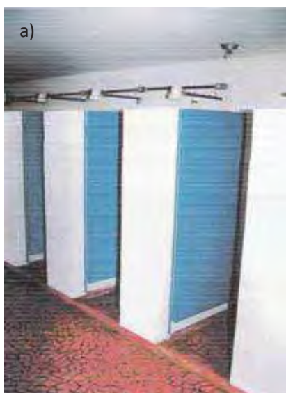
Imagem 8: a) Porta das duchas do vestiário com menos de 80 cm (BRANCATTI, 1999); b) Ducha que foi adaptada anos depois, mas com adaptações que não seguem a ABNT 9050 (BRANCATTI, 1999).
