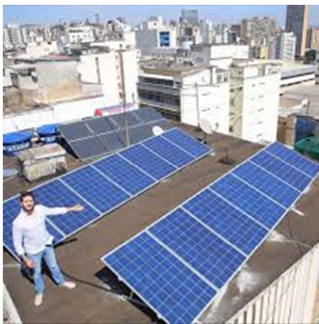
Figura 3 - Telhado típico de domicílio do tipo apartamento.
