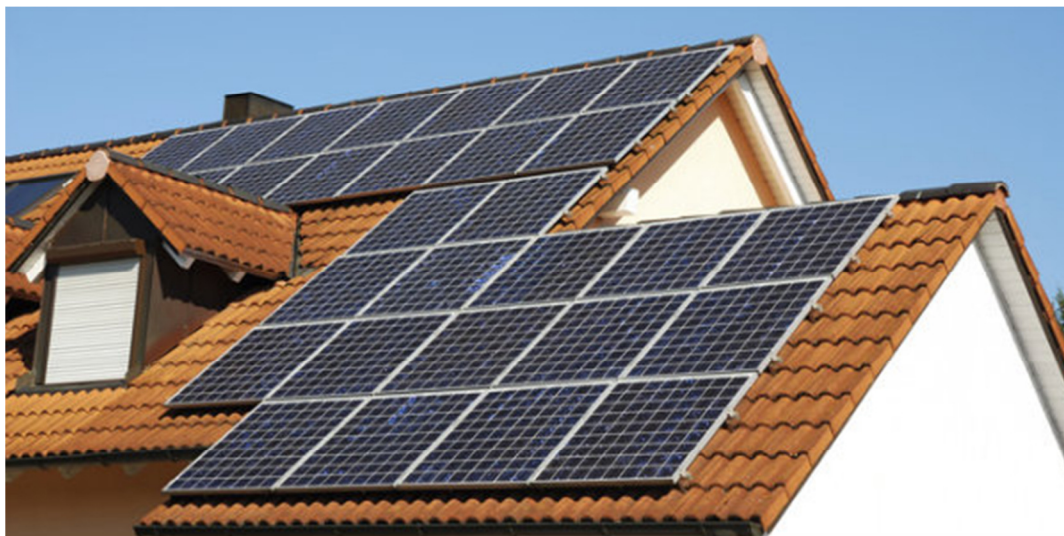
Figura 2 – Telhado típico de domicílio do tipo casa.
