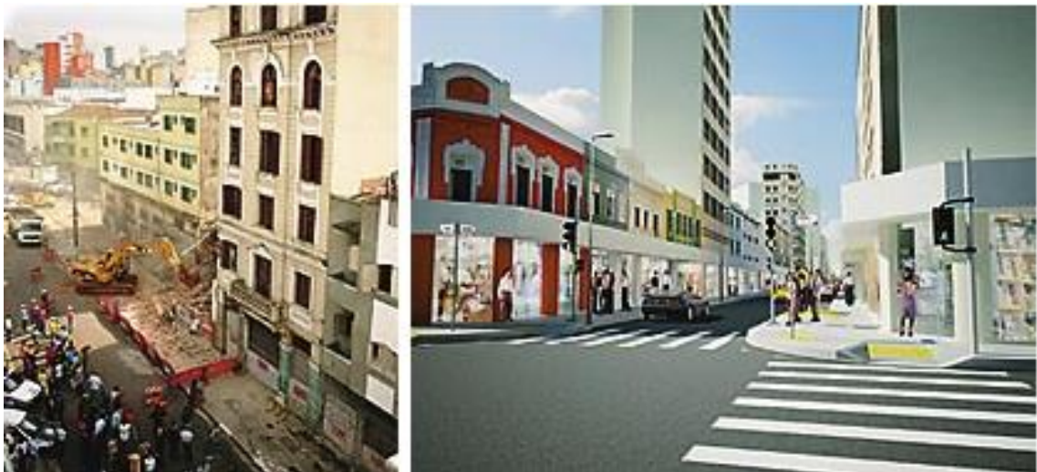
Figura 7 – Demolições (esquerda) darão lugar à novos prédios (direita)
