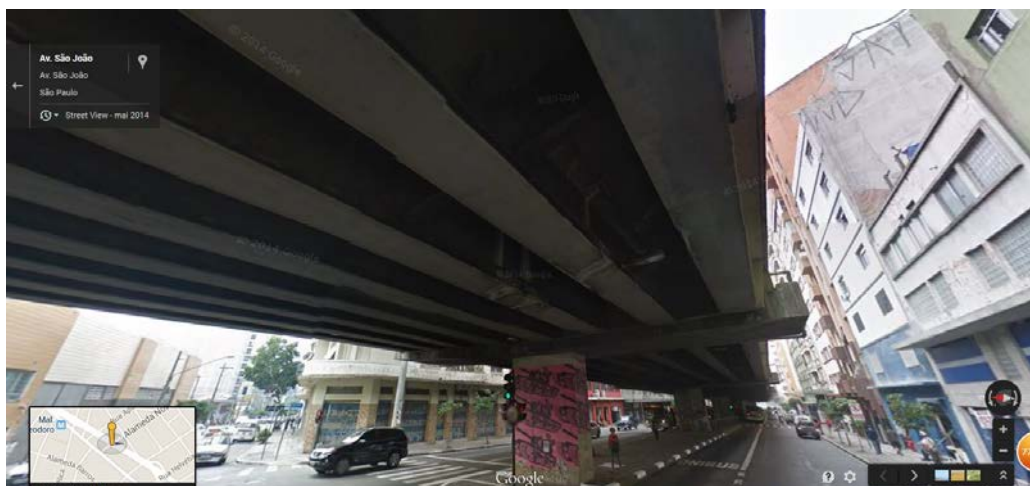
Figura 14 – Estrutura do Elevado no nível da Rua São João
