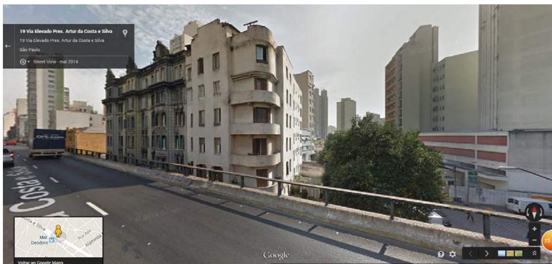
Figura 12 – Proximidade da via dos prédios
