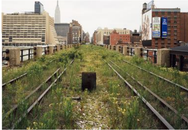
Figura 25 – Antes da intervenção: A via encontrava-se abandonada tomada por vegetação
