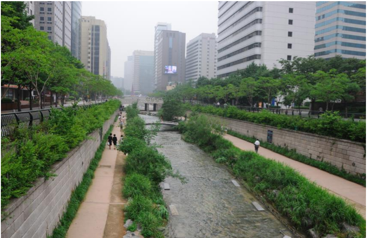
Figura 34 – A água ao longo do parque além de ser limpa, diminui a temperatura na região ao redor.
