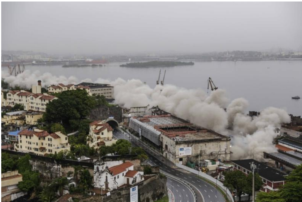
Figura 22 – Demolição de trecho da Via Elevada Perimetral.
