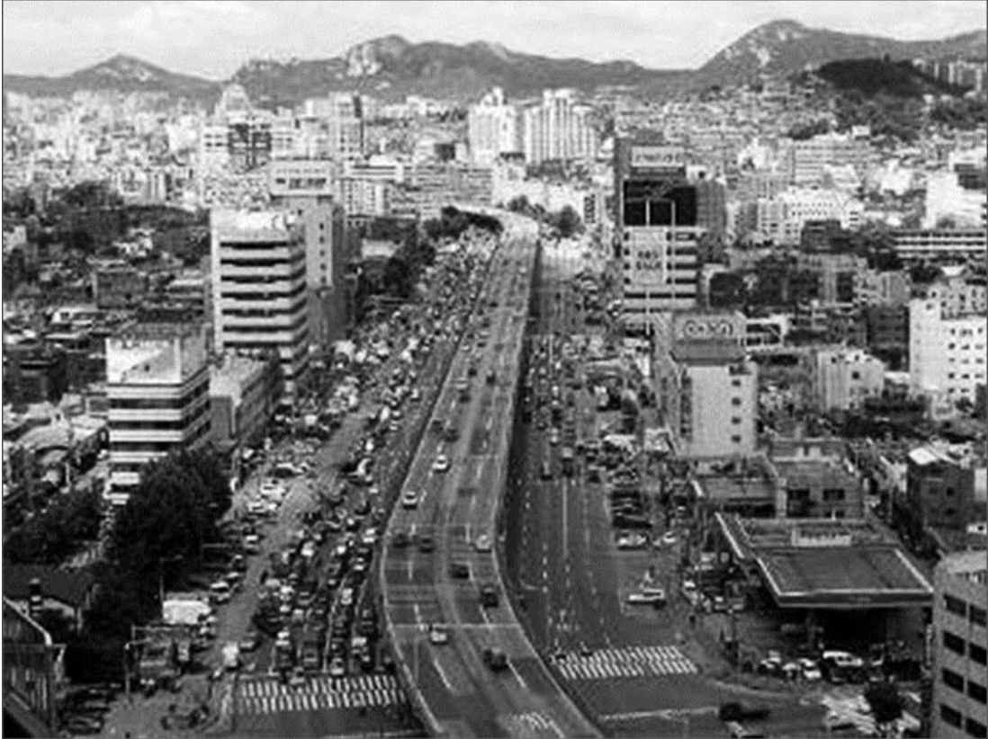
Figura 32 –Antes da intervenção: Córrego enterrado
