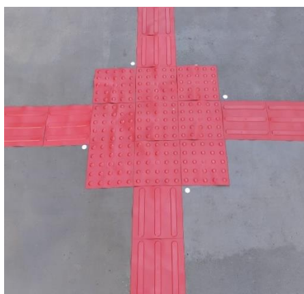
Imagem 67 – Etiquetas RFID fixadas próximas ao piso tátil
