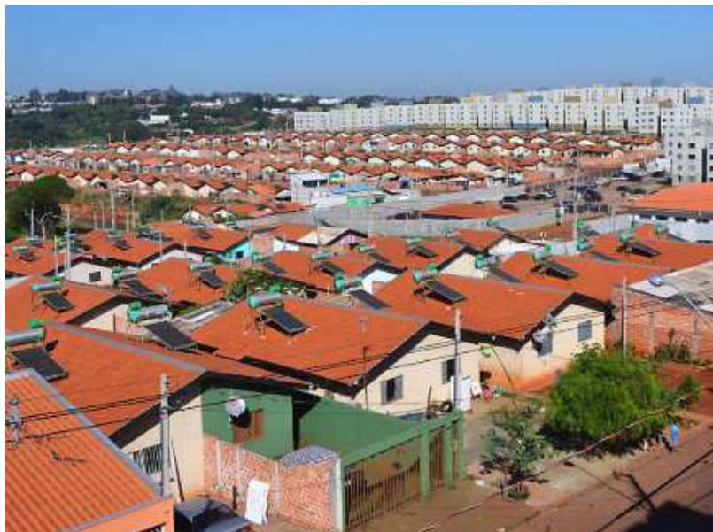
Figura 2 – Unidades habitacionais unifamiliares do Residencial Vista Bela (Londrina - PR) com sistema de aquecimento solares compactos instalados
