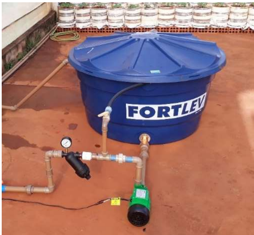
Figura 5 – Sistema de bombeamento e reservatório de água para irrigação
