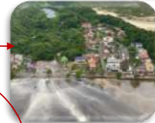
Rompimento de ETE Florianópolis / 2021
