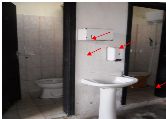
Figura 4: Sanitários restaurante B
