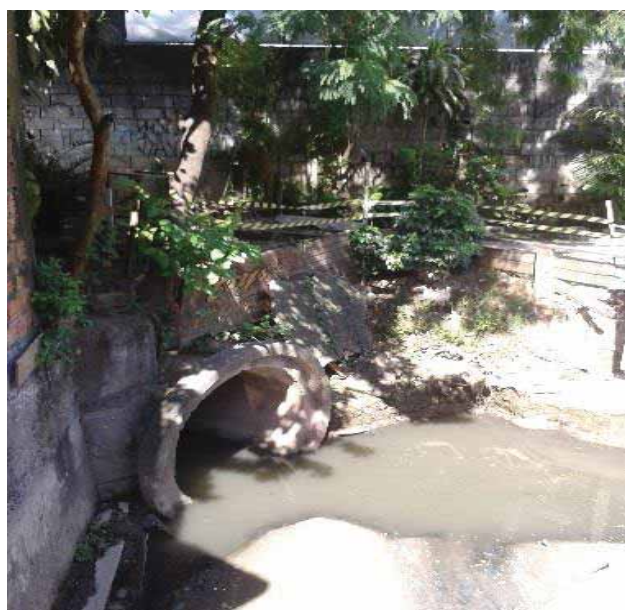
Foto 4: Tubulação da rede de esgoto aberta em frente a uma residência na avenida Nossa Senhora do O. Foto: SIMAS, 2013.
